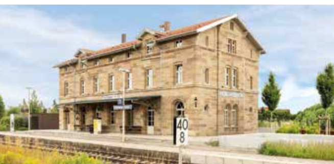
Bahnhof Eckartshausen – ausgezeichnet mit dem Denkmalschutzpreis Baden-Württemberg
